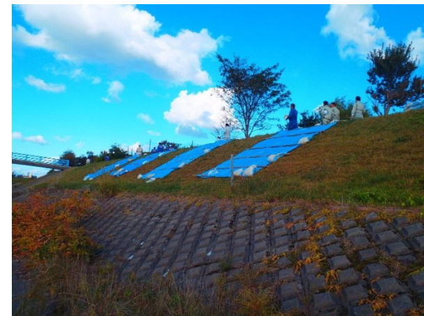
水防技術講習会(シート張り工法)
