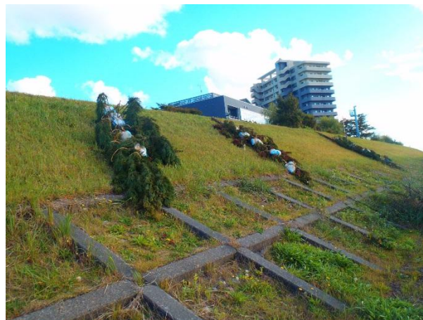
水防技術講習会(木流し工法)
