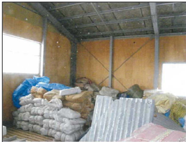
水防倉庫修繕前
