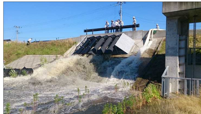
排水機場・排水ポンプの排水状況
