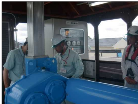
三条市による樋門の操作訓練状況
