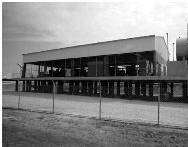
ポンプ稼働機械架台のピロティー方式による耐水化
