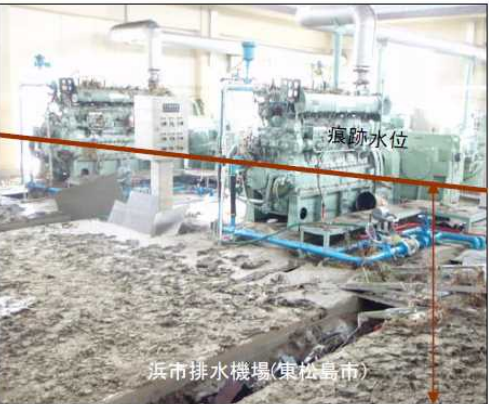
排水機場の被災（原動機等も水没、損壊）
