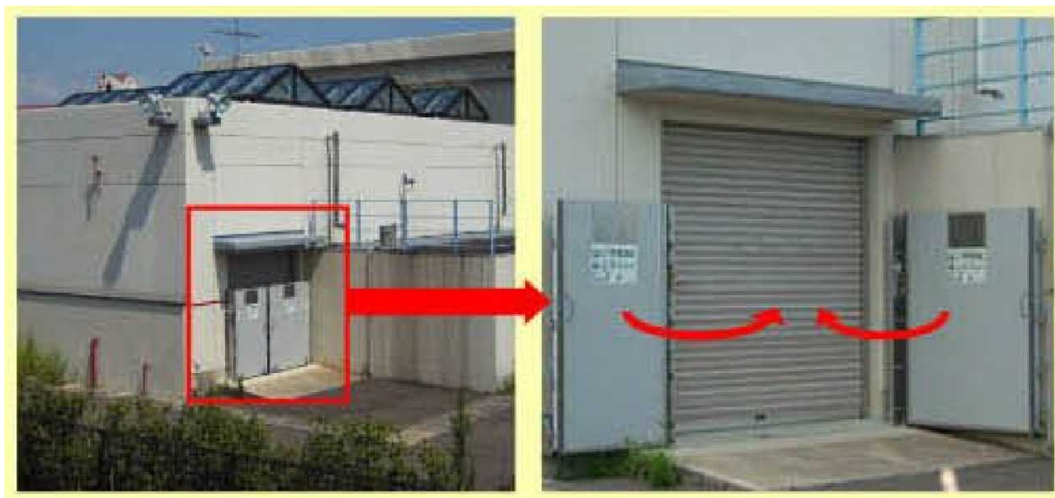
洪水時は閉鎖され、浸水を防止する
