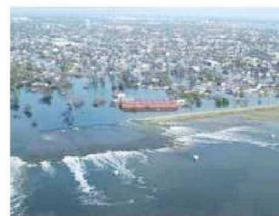
破堤箇所(⑥地点)
