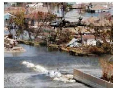
破堤箇所(①地点)
