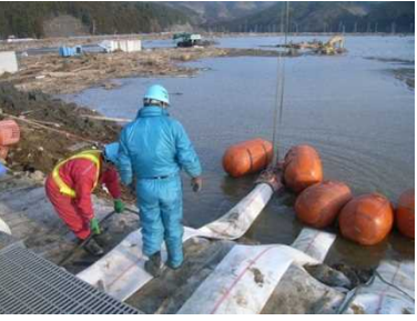
排水ポンプ車による排水状況
