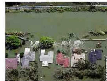
破堤箇所(②地点)
