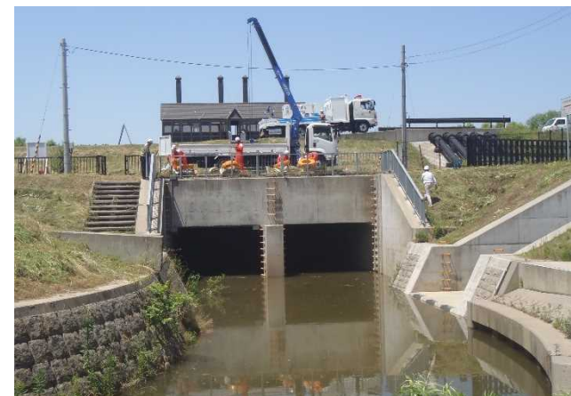
国による排水ポンプ車の訓練状況
