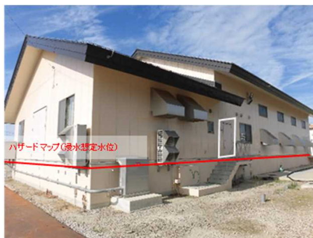
旧木山川排水機場 建屋
