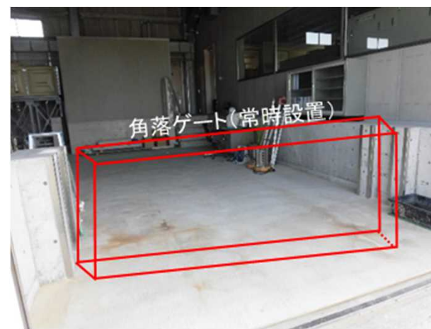
旧木山川排水機場 搬入口
