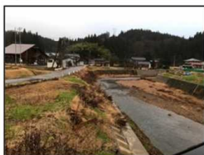
水位計設置場所付近の様子
