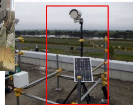
簡易型河川監視カメラ
