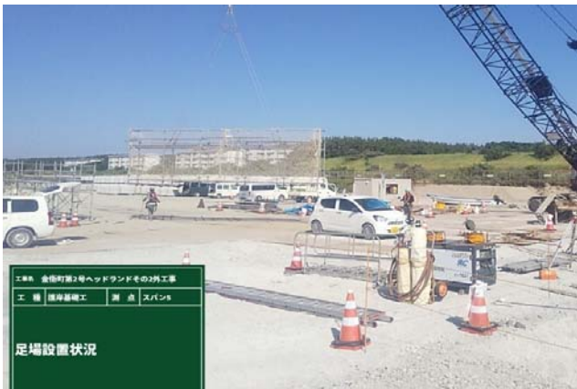
足場設置状況
