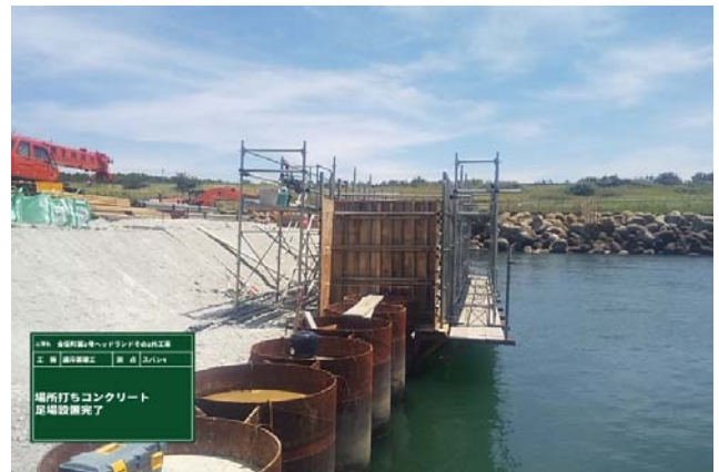
足場設置完了
