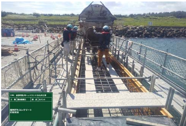
足場使用状況
