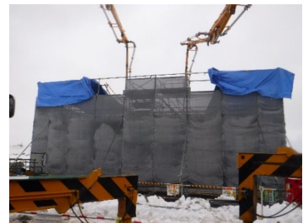
写真-10 雨養生状況
