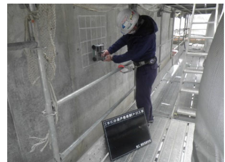
写真-17 非破壊試験 配筋状態及びかぶり測定状況（堅壁）
