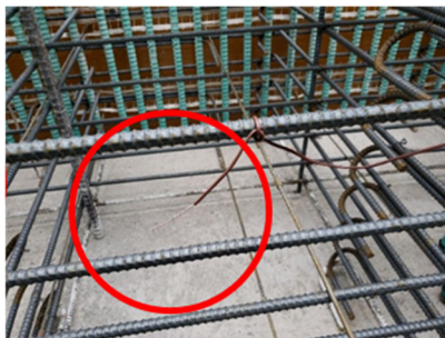
写真-2 温度センサー設置状況
