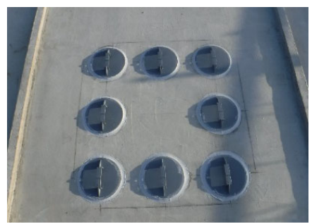
写真-13・14 支承・ダンパー箱抜き実施状況
