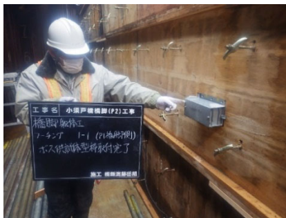
写真-15 微破壊試験 ボス型枠設置状況（フォーミング）
