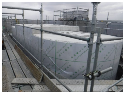
写真-4 脱枠後保温・保湿状況
