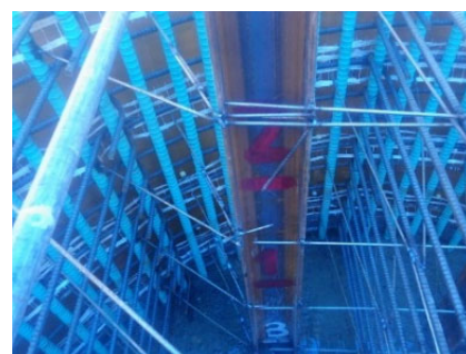
写真-7 セパレーター溶接用の H 型鋼設置状況
