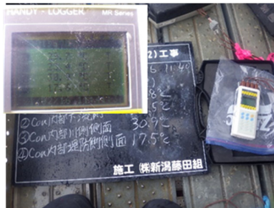
写真-3 コンクリート温度測定状況
