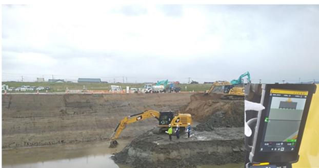
写真-1 掘削工（3D マシンコントロール）
