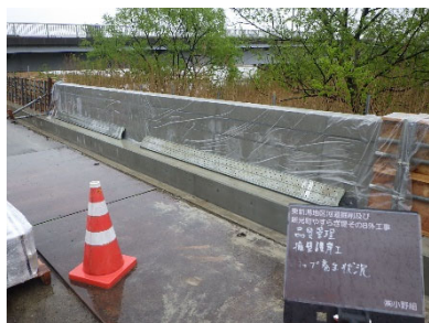
図-10 封かん養生実施状況
