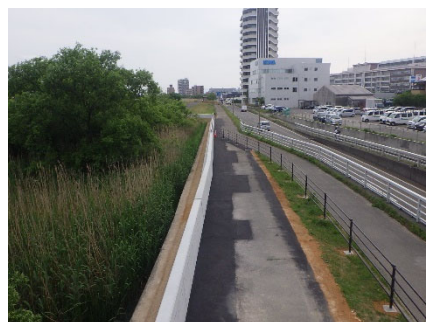
図-13 擁壁護岸完成写真 (千歳大橋上流側)
