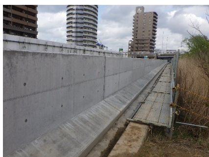
図-11 擁壁護岸 前面側
