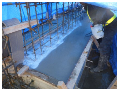
図-8 打ち継ぎ目処理剤 散布状況
