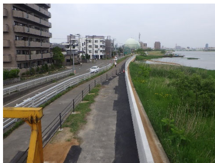
図-12 擁壁護岸完成写真 (千歳大橋下流側)
