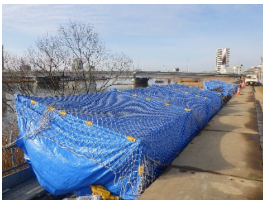
図-7 雪寒仮囲い設置状況
