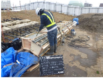
図-4 試験施工実施状況
