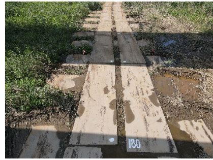
鉄板の補強対策
