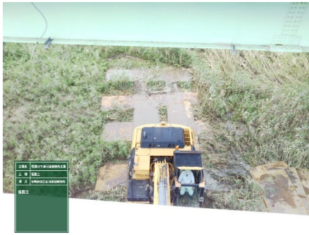
鉄板の敷設状況
