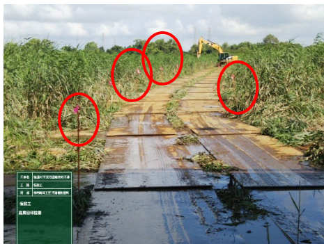
鉄ピンの設置（鉄板2枚に1本）
