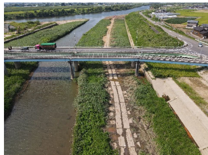
鉄板敷設全景（上流部より撮影）
