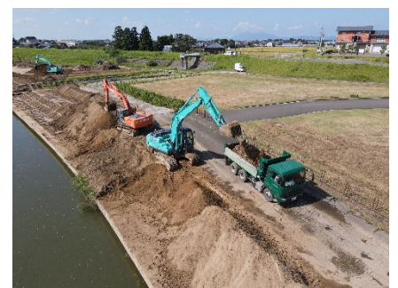
掘削工・積込運搬
