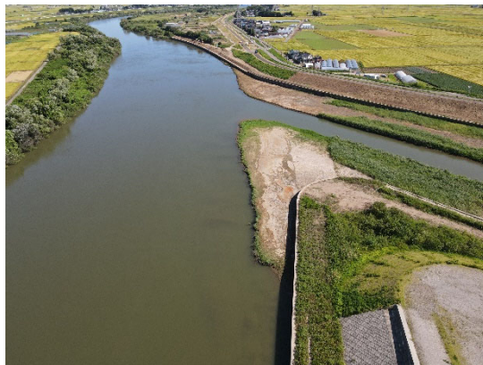
加茂川合流部の掘削完了
