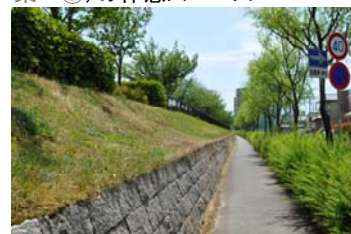
堤脚部(用語集⇒⑥)の道路幅を確保する腰積擁壁
