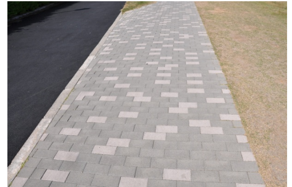
■萬代橋上流（右岸）の自然石張り舗装
