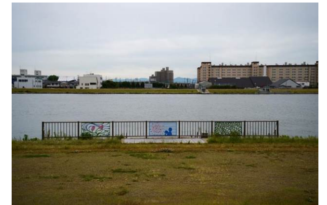
■樋門放水口の転落防止柵（左岸）。花火や草花のモチーフがやや唐突な印象がある。
