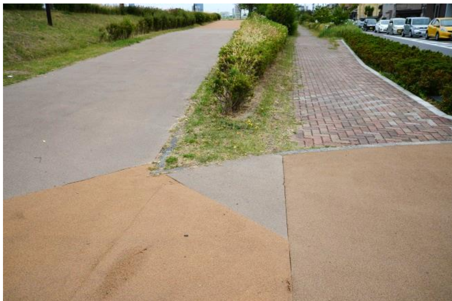
■施工年次の違いにより、舗装材や色彩がツギハギ状になっている箇所もある。
