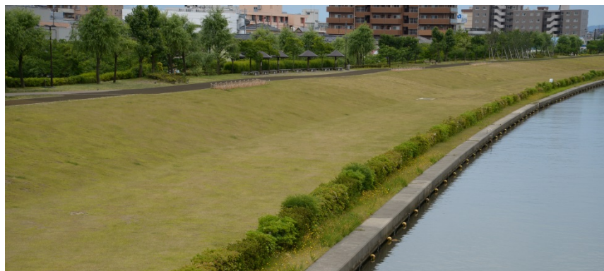
■ 堤防背後を縁取る緑のエッジが、やすらぎ堤ならではの潤いある河川景観を形成している(八千代橋上流右岸)。
