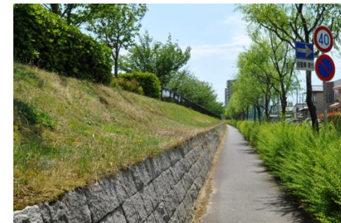
堤脚部の道路幅を確保する腰積擁壁
