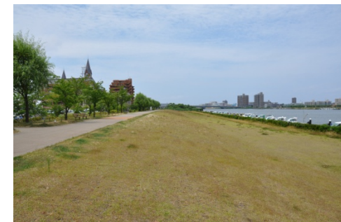
ラウンディングにより自然的な印象となっている堤防法肩部
