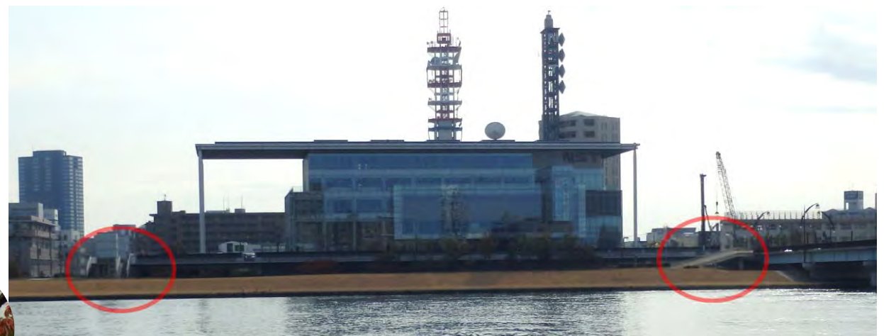
NSTからの歩道橋
