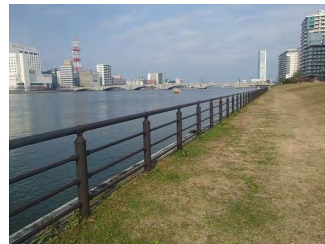
防護柵(鋼製防護柵、横棧)
