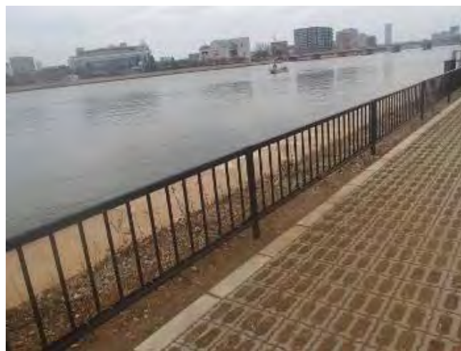
防護柵(鋼製防護柵、縦棧)
