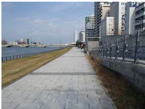
舗装(自然石平板舗装)
