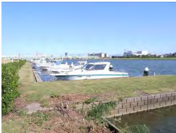
暫定係留施設
