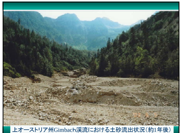
上オーストリア州Gimbach渓流における土砂流出状況(約1年後)
