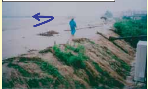
③ 水田の冠水状況(南入蔵付近)
