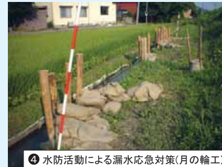
⑤ 水防活動による漏水応急対策(月の輪工)
