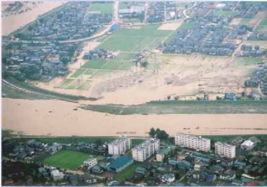
五十嵐川破堤地点(三条市諏訪地区)
