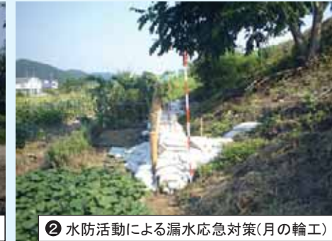
① 水防活動による漏水応急対策(月の輪工)
