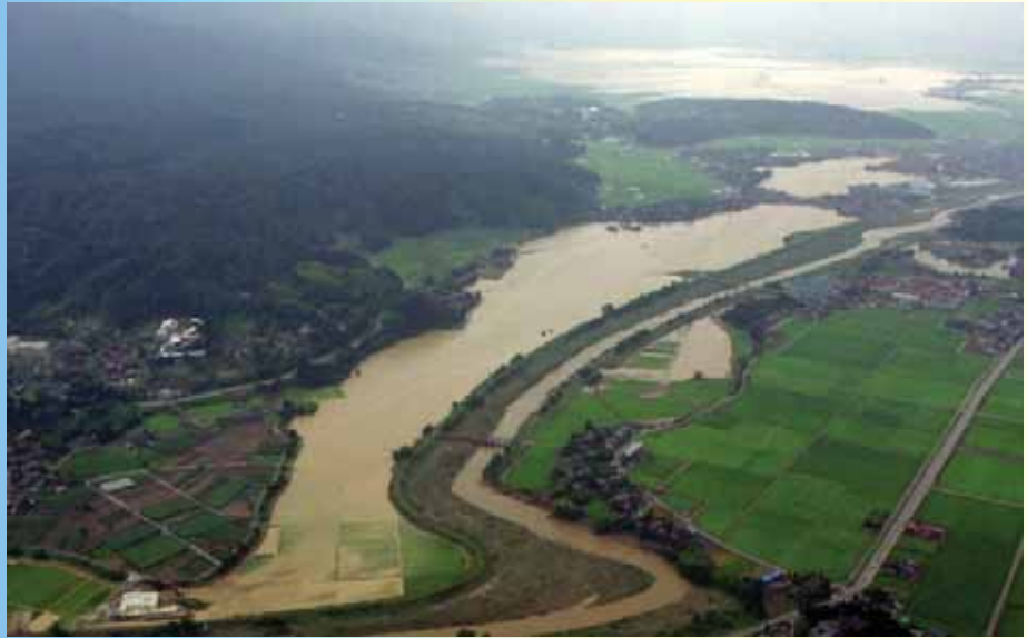
刈谷田川破堤地点(見附市本明町・明晶町・庄川町)
