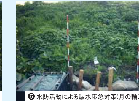
④ 水防活動による漏水応急対策(月の輪工)
