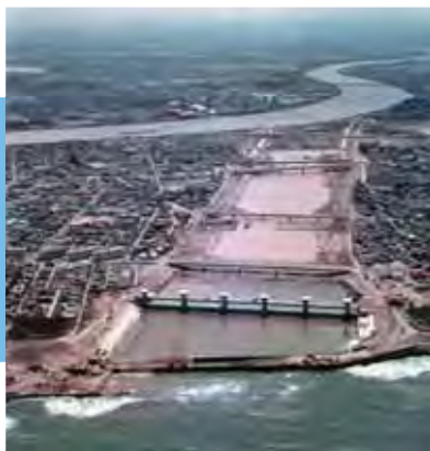
掘削がほぼ完了した関屋分水路 (昭和46年6月撮影)
