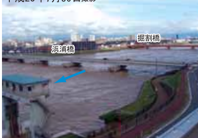
洪水を安全に流している関屋分水路
