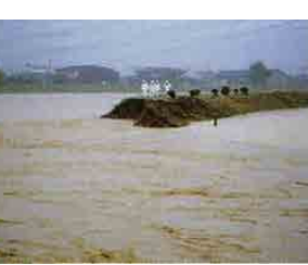
破綻した五十嵐川(平成16年7月)
