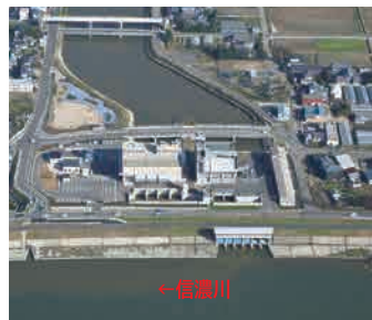
鳥屋野潟排水機場(写真中央右側の建物)
