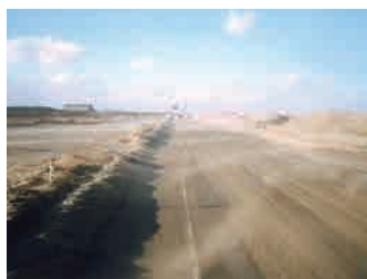
国道402号線飛砂状況 (平成17年)
