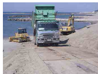
養浜状況(金衛町工区)
