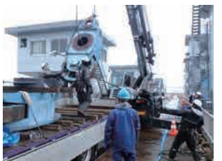
中ノロ川水門 主ローラ補修
