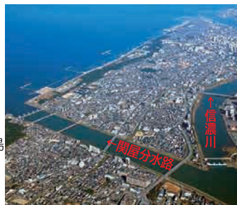
関屋分水路と信濃川(新潟市)
