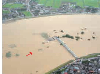
小須戸橋の状況(平成23年7月)
