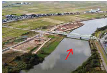
新潟市南区戸石地区 河道掘削状況
