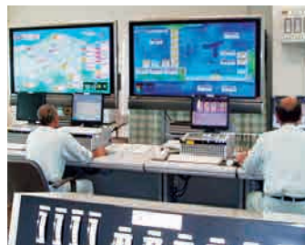
操作室（新潟大堰）
