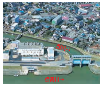
西川排水機場
