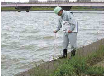
施設点検状況
