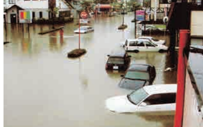
大堀幹線の浸水状況(平成10年8月)
