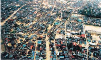
五十嵐川の堤防の決裂による三条市の浸水状況(平成16年7月)
