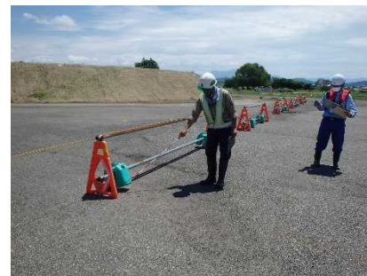
三条市民憩いの広場点検 (三条防災ステーション)
