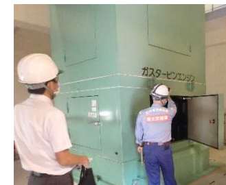
西川排水機場点検整備
