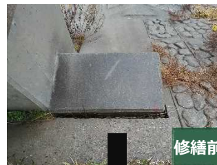
前須田樋門目地修繕
