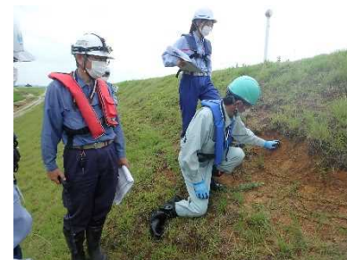
戸石堤防表法面
