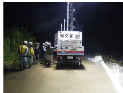
14 排水ポンプ車・照明車の設営（夜間）
