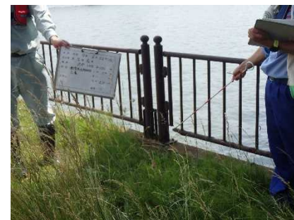
関屋分水路点検
