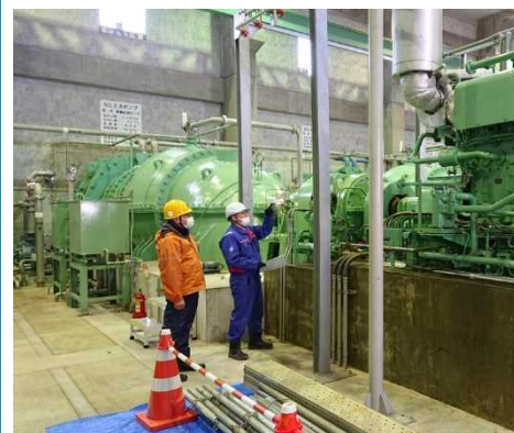
西川排水機場 原動機修繕工事
