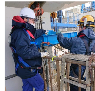
新潟大堰ゲート点検整備
