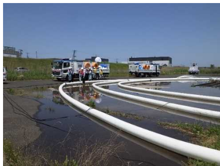
排水ポンプ車の設営
