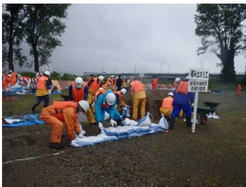
積み土のう工
