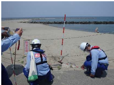
関屋浜海水浴場 陥没
