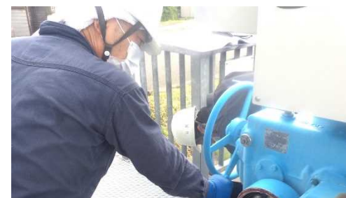
山島新田雨水排水樋門 開閉機点検
