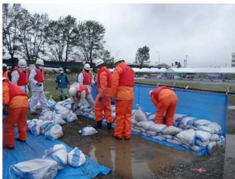
改良積み土のう工
