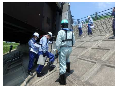
亀鶴橋取付護岸・ブロック積み
