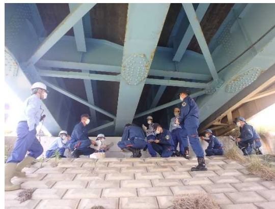
13 6/2 信濃川大橋(左岸6.58k)
