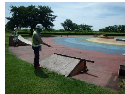
信濃川親水緑地公園点検 (小須戸運動公園)
