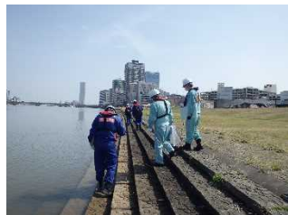
護岸等の点検
