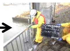
樋管門柱部の転落防止柵修繕
