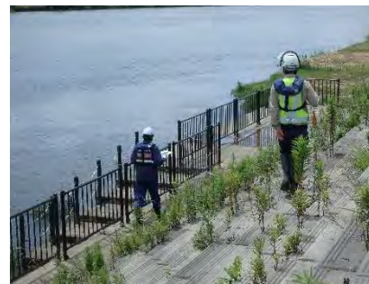
三条市民憩いの広場点検
