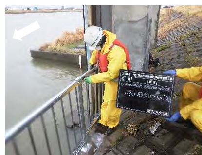
新転落防止柵の設置
