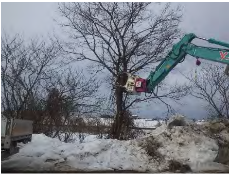
河道内樹木の伐採状況
