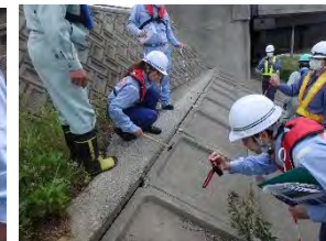
亀鶴橋取付護岸
