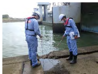
新潟大堰下流左岸取付護岸平張部
