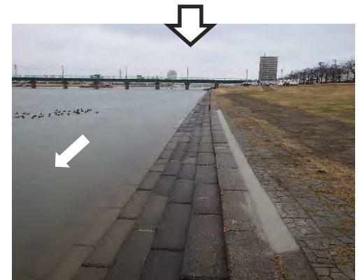
階段護岸補修作業完了後
