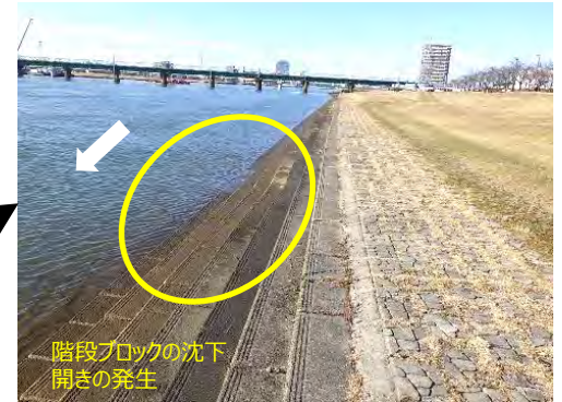
階段護岸補修前
