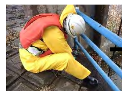
樋管門柱部の転落防止柵修繕
