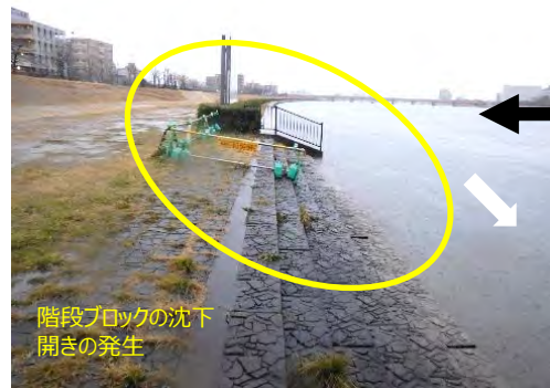
階段護岸補修前
