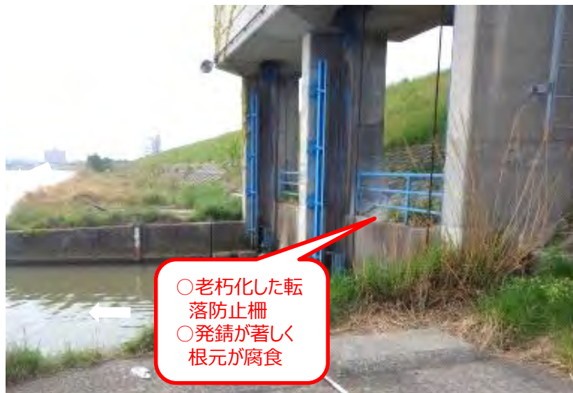
西川排水樋管
