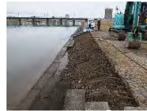
階段護岸補修作業状況
