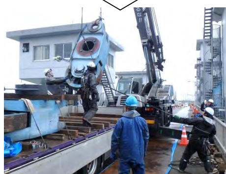
中ノ口川水門 主ローラ補修
