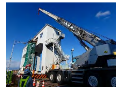
西川水門設備更新工事
