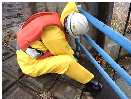
発錆が著しく老朽化した 旧転落防止柵の撤去
