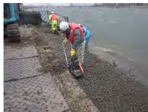
階段護岸補修作業状況
