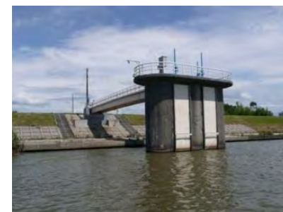
新潟市上水道取水塔
