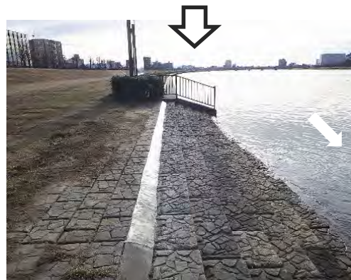
階段護岸補修作業完了後
