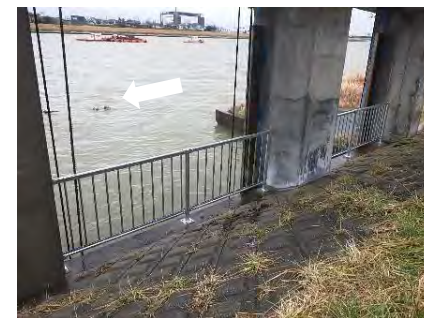
新転落防止柵の設置
