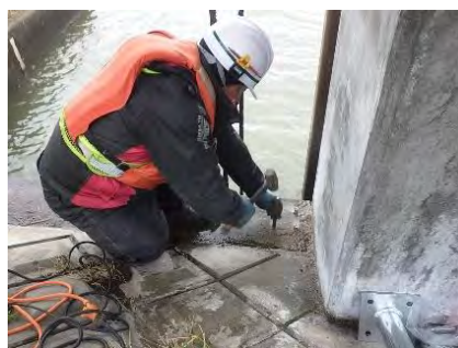
更新用固定金具設置
