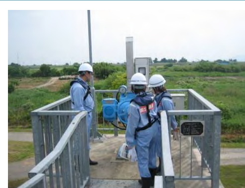
子成場雨水排水樋門点検（直轄管理）
