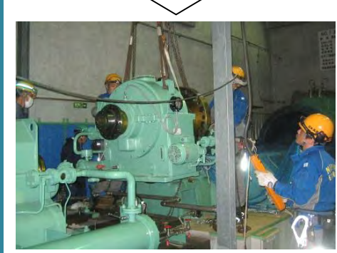
排水ポンプ分解整備
