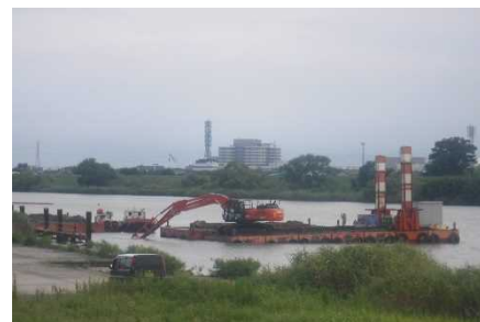
(ICT 河川浚渫工事の施工状況)
