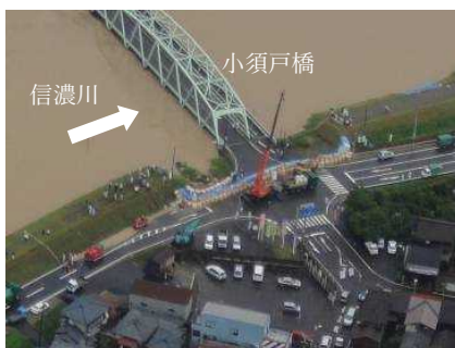
水防活動状況（H23.7 出水）
