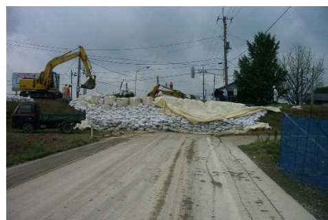
水防活動状況（H16.7 出水）
