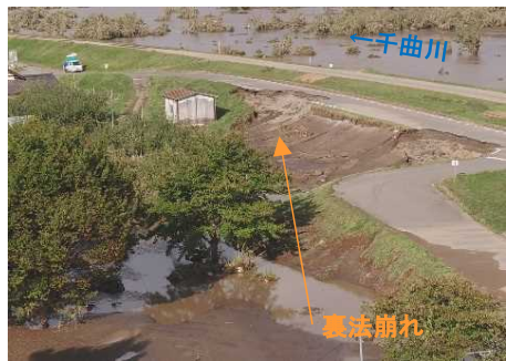
①決壊地点下流側の裏法崩れ 10月13日 14:00撮影
