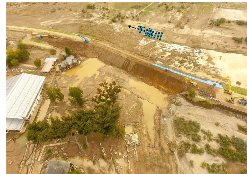
図-4 測量時空撮・仮堤防完成時 (2019. 10. 18撮影)
