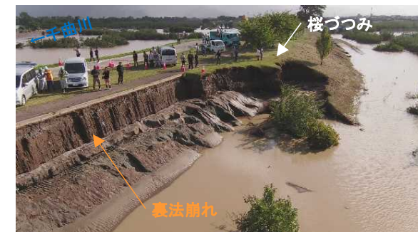
③決壊地点上流の裏法崩れ 10月13日 14:50撮影
