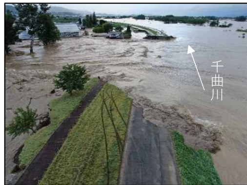
被災状況（長野市穂保地先） （令和元年10月13日 7時00分）
