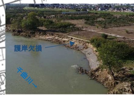
⑥護岸欠損 11月2日 9:20撮影
