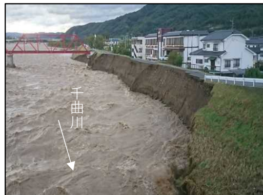
被災状況（上田市諏訪形地先） （令和元年10月13日 7時10分）
