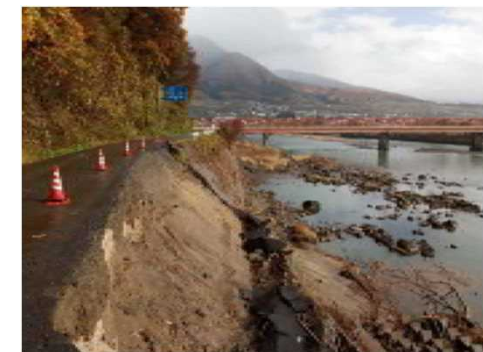
市道の早期復旧・査定前着工の要望（飯山市）
