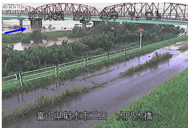
8/14 11:20 庄川右岸7k0 大門大橋付近【射水市二口】 (氾濫注意水位超過状況)
