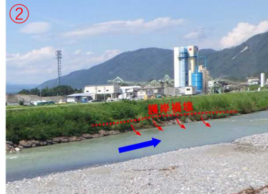
応急復旧着手前
