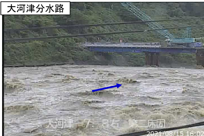
8/15 16:02 大河津分水路右岸7k8 第二床固付近【燕市渡部】 (水防団待機水位超過状況)
