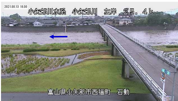
8/13 16:00 小矢部川左岸25k4 石動観測所付近【小矢部市西福町】 （水防団待機水位超過状況）
