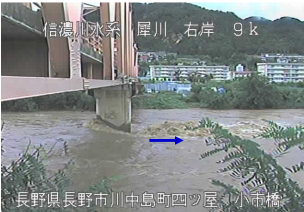
長野県長野市川中島町四ツ屋 小市橋 8/15 12:00 犀川右岸9k0 小市橋付近【長野市 川中島町】 (氾濫注意水位超過状況)
