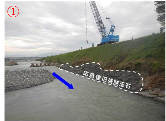
応急復旧完了
