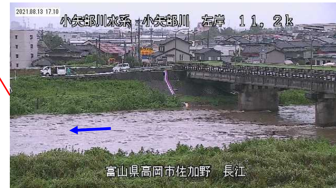
8/13 17:10 小矢部川左岸11k2 長江観測所付近【高岡市佐加野】 （氾濫注意水位超過状況）
