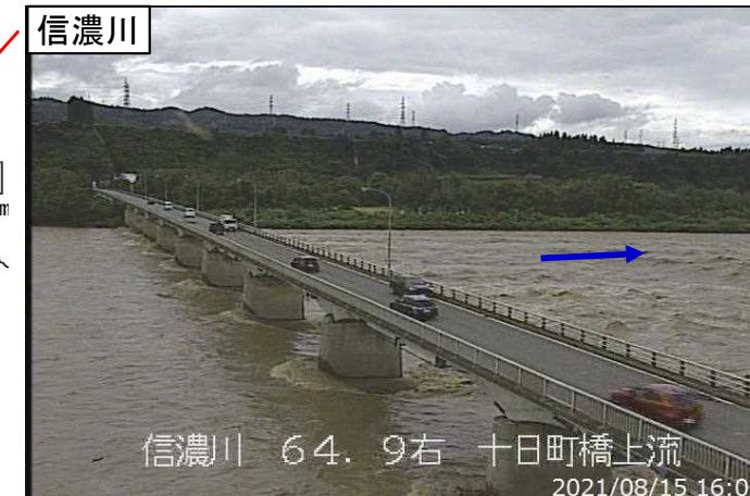
8/15 16:03 信濃川右岸64k9 十日町橋上流付近【十日町市高田町】 (氾濫注意水位超過状況)
