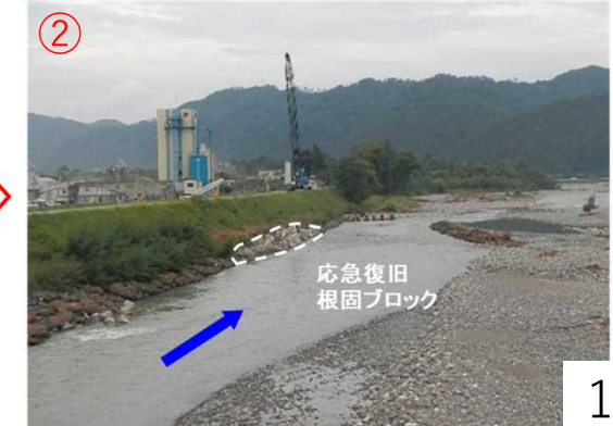
応急復旧完了
