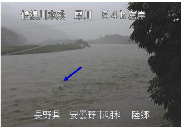
8/15 8:30 犀川左岸54k0 陸郷付近【安曇野市明科】 (氾濫危険水位超過状況)
