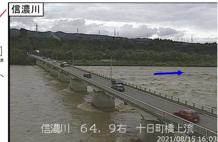
8/15 16:03 信濃川右岸64k9 十日町橋上流付近【十日町市高田町】 (氾濫注意水位超過状況)
