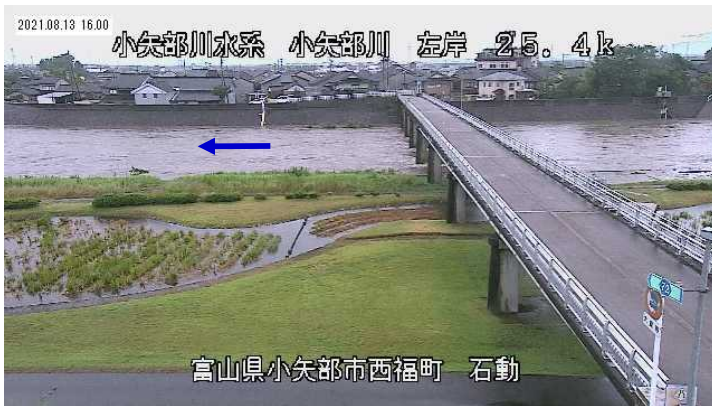
2021.08.13 16.00 小矢部川水系 小矢部川 左岸 25.4k 富山県小矢部市西福町 石動 8/13 16:00 小矢部川左岸25k4 石動観測所付近【小矢部市西福町】 (水防団待機水位超過状況)
