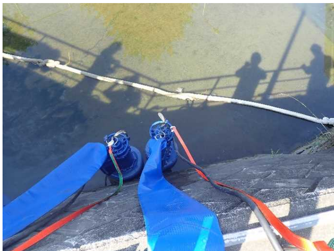
排水ポンプ設置箇所確認 (大牟田市 三川ポンプ場)
