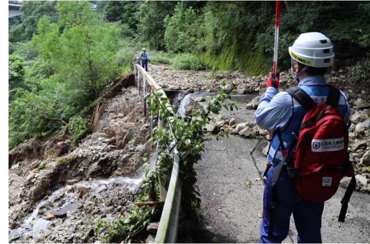
①村道側道15号線 現地調査
