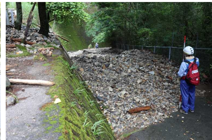
①村道側道15号線 現地調査
