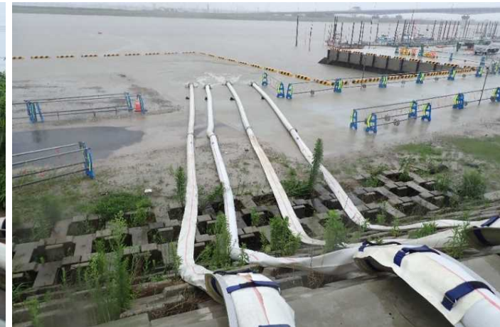
②南百姓樋管(排水ポンプ稼働状況)
