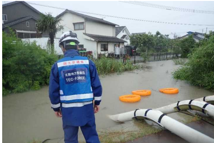
①南百姓樋管(排水ポンプ稼働状況確認)
