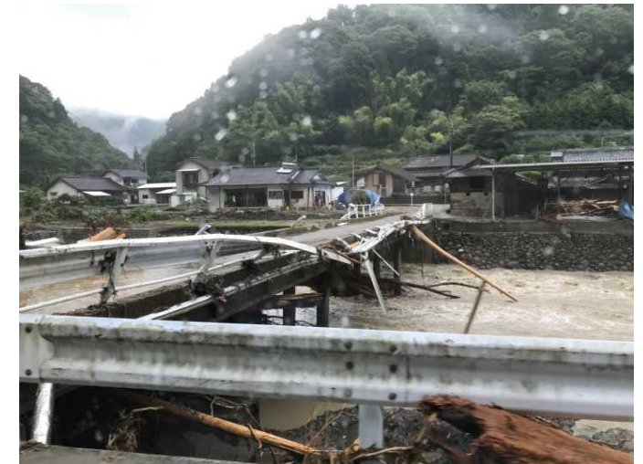
山江村地内の被災状況 (県道17号から村道涼松横手線へ向かう橋梁)
