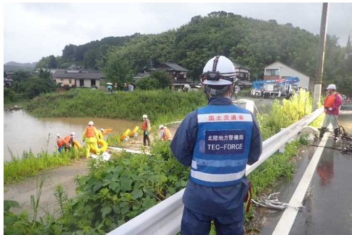
③矢部川(北山地区)排水機場 (排水ポンプ設置)
