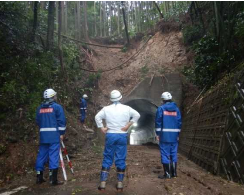
②下城(建設水道課長と現地確認)
