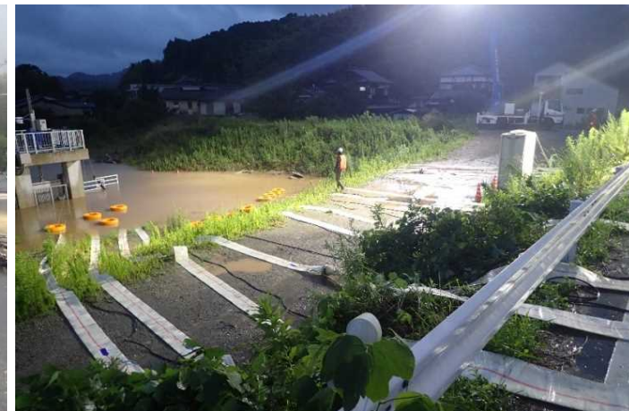
④矢部川(北山地区)排水機場 (排水ポンプ設置)
