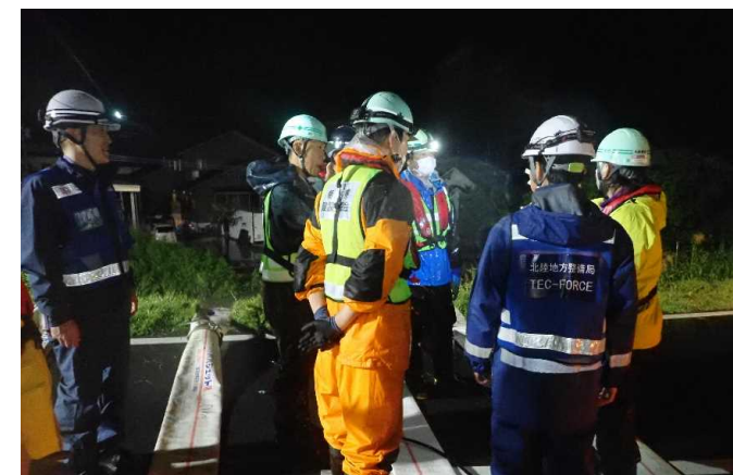
④南百姓樋管 設置状況確認
