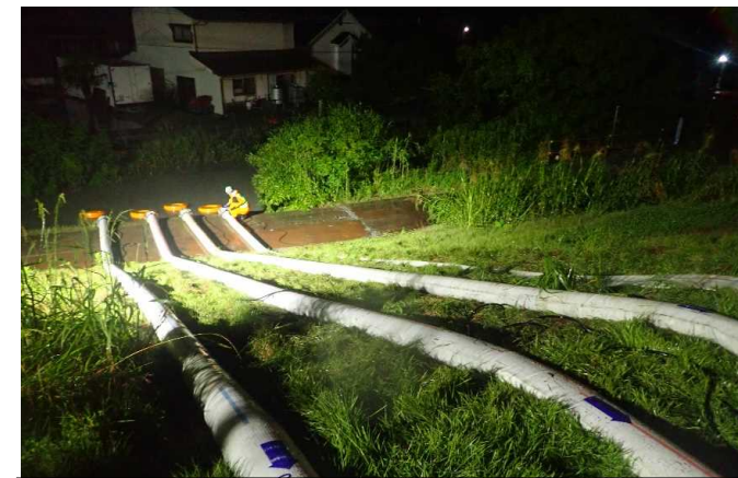
②南百姓樋管 排水ポンプ設置
