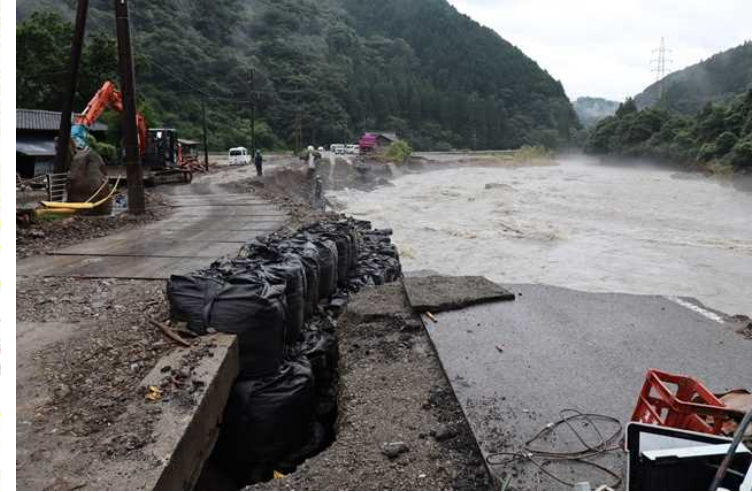
山江村地内の被災状況(県道17号)
