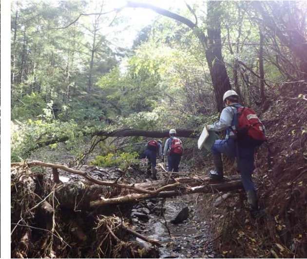
和熊川 被災状況
