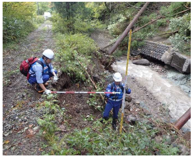
和熊川 被災状況
