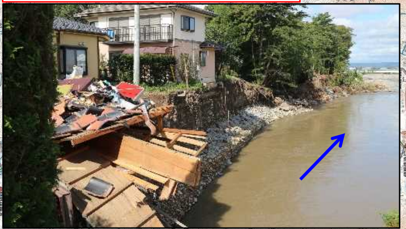
【千曲川：護岸崩壊】 長野県 佐久市 原地先～佐久穂町 高野町 地先
