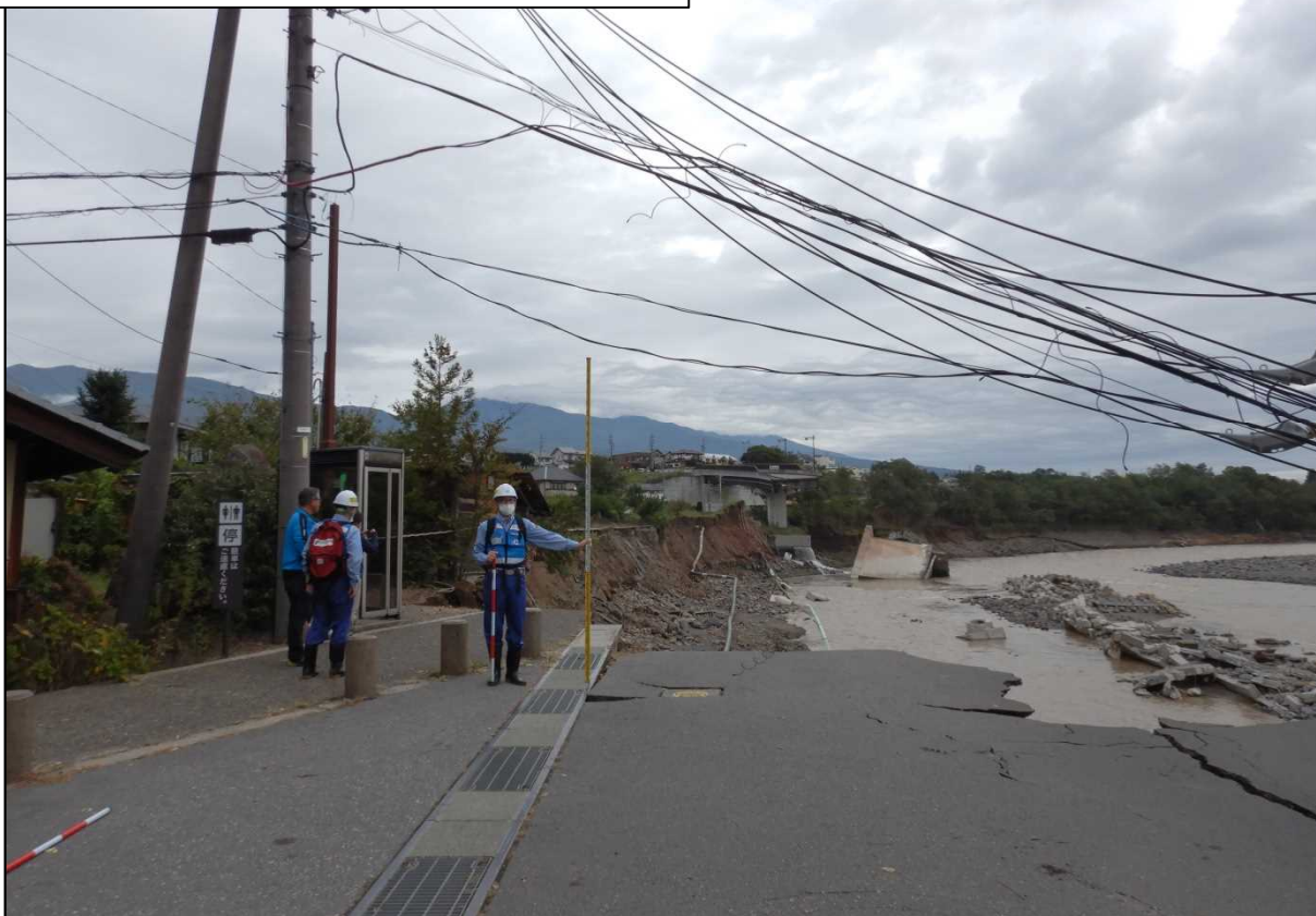
被災状況調査【河川】(東御市)
