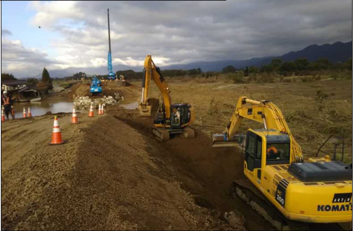
路面清掃状況 飯山市内
