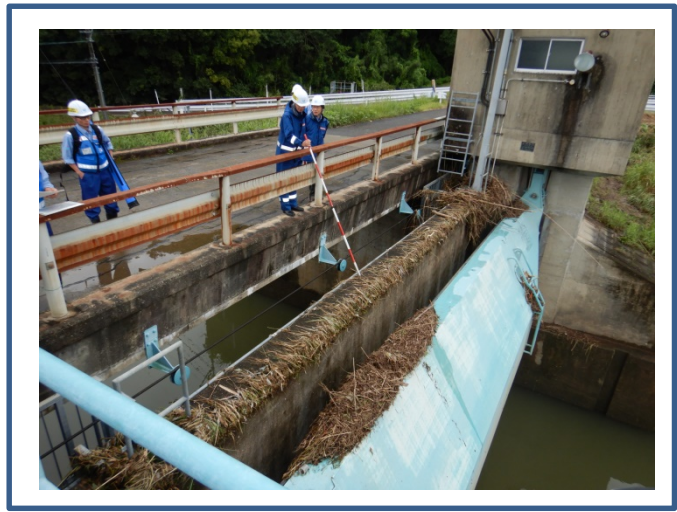
山崎排水機場(L10.1k) 洪水痕跡状況確認
