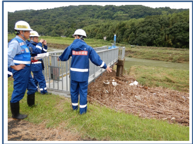
樋門 流木等堆積状況確認
