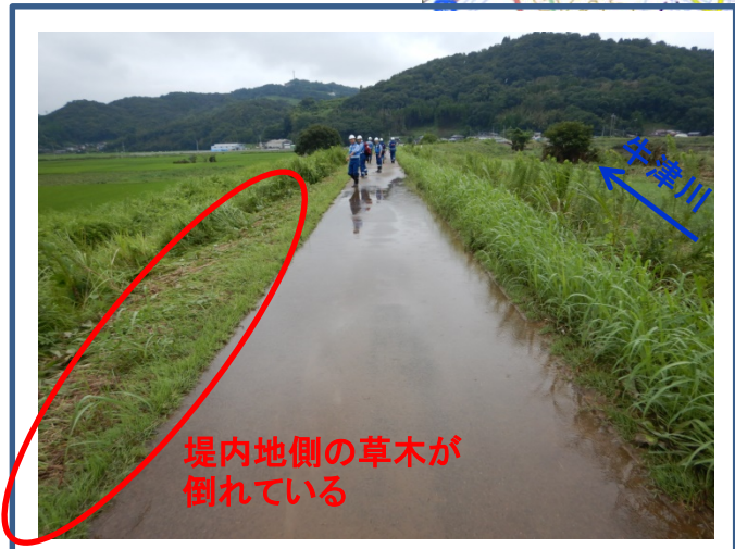
越水痕跡状況確認(L12.4k)
