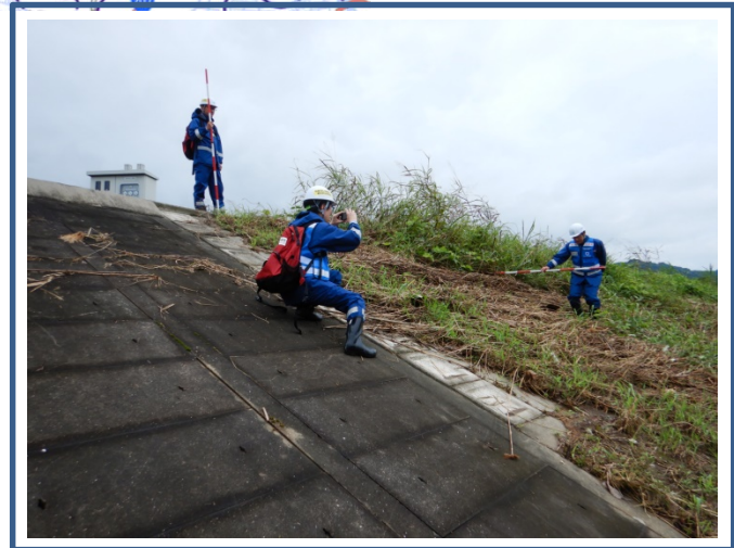
永瀬川排水機場(L13.7k) 洪水痕跡状況確認
