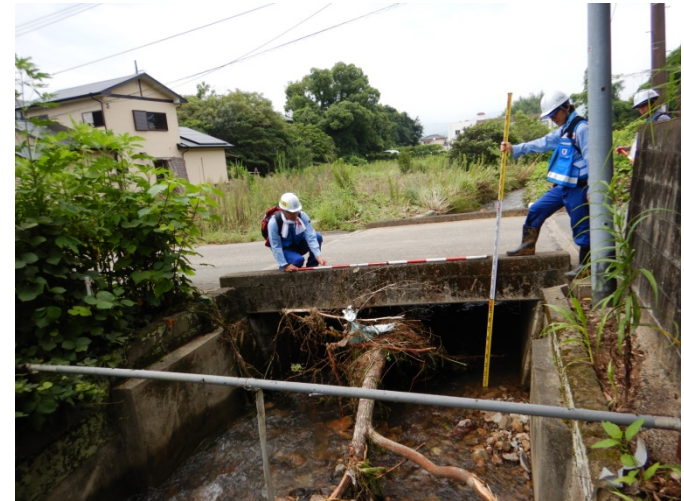
六田川(中流域) 流木による閉塞状況
