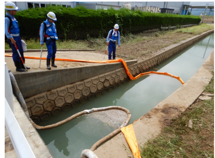
六田川(下流端) オイルフェンス設置状況
