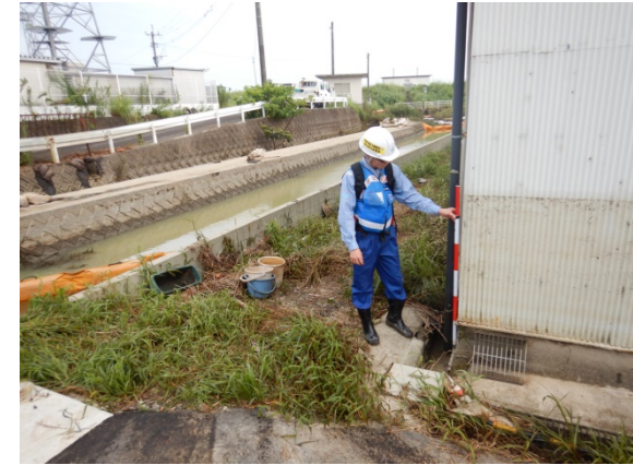
沖の神川 浸水痕跡状況
