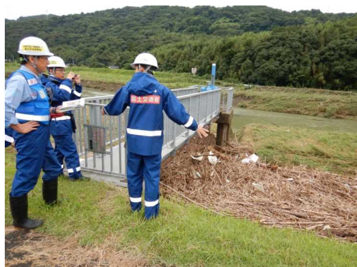
9月1日 牛津川 流木等堆積状況調査 (佐賀県多久市)
