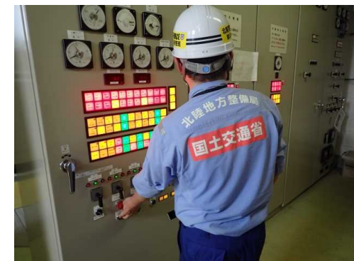
9月5日 操作盤等 稼働状況確認
