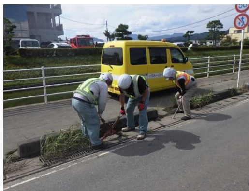
9月3日 側溝清掃状況 (佐賀県杵島郡大町町)
