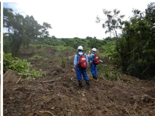
8月31日 沖の神川 河岸崩落状況調査 (佐賀県杵島郡大町町)
