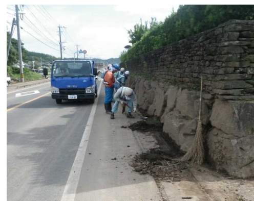
9月3日 路面清掃状況 (佐賀県杵島郡大町町)
