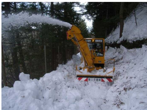
南巨摩郡早川町内 (2/23 作業)
