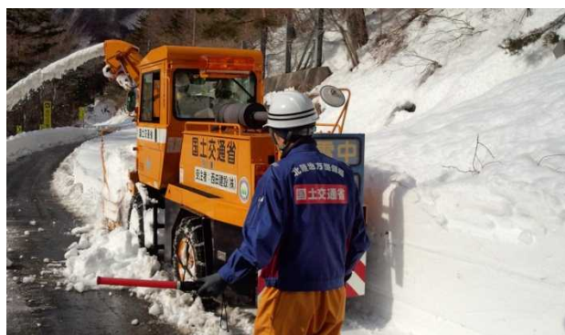
甲府市古関町地先 (2/19 作業)
