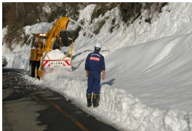
北杜市須玉町比志地先 (2/18 作業)
