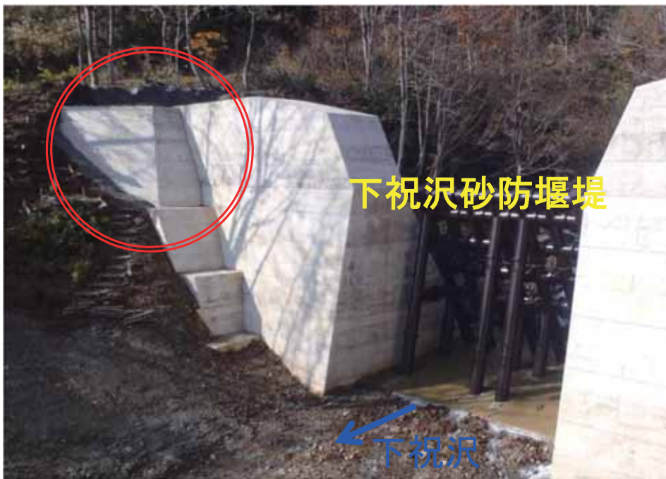
H23.12本堰堤完成時
