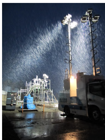
↑夜間照明による監視状況
