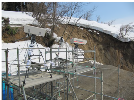
←監視カメラの設置状況(頭部)
