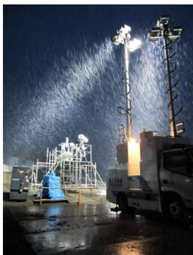
↑夜間照明による監視状況
