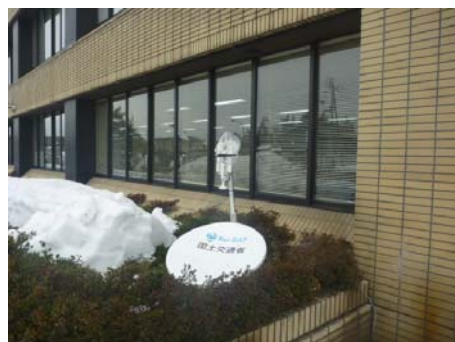
↑上越市板倉区総合事務所のKU-SAT設置状況
