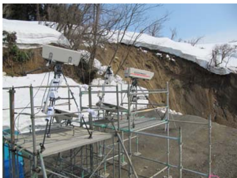
←監視カメラの設置状況（頭部）
