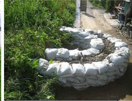
嘉瀬島川裏「月の輪」による堤防漏水対策(右岸20.4Kp)
