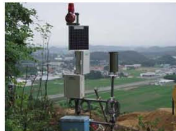
電源、通信装置 設置事例
