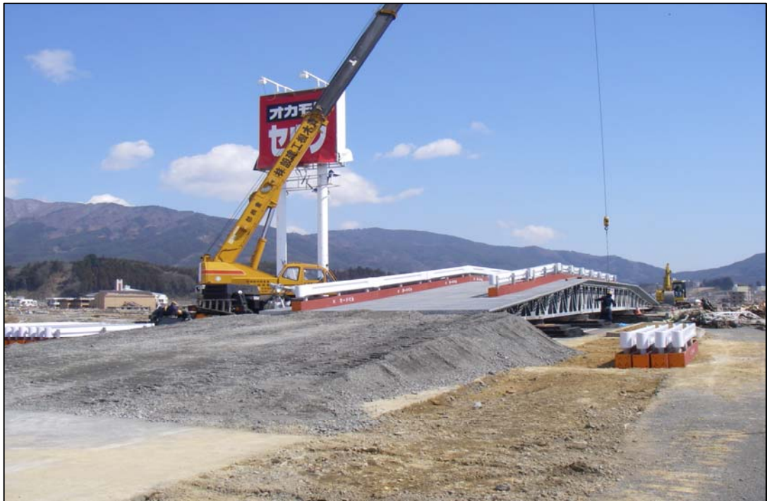
3/24現在の作業状況(取付部舗装後、25日完成予定)
