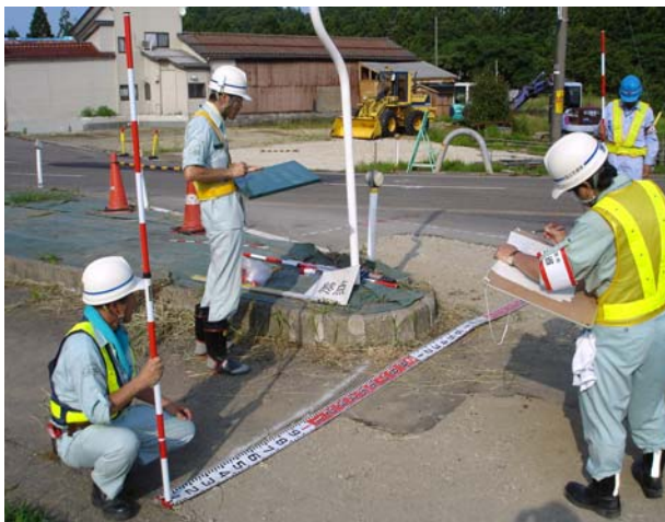
現地調査状況
