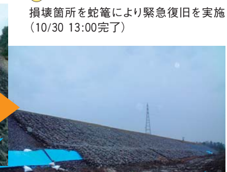
⑥ 十日町市高島緊急復旧完了 蛇管、シート張りによる緊急復旧を実施(10/30 13:00完了)
