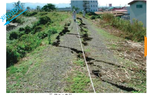
④ 中之島町五百刈堤防天端亀裂(県管理河川) 信濃川右支川刈谷田川左岸の堤防天端に亀裂
