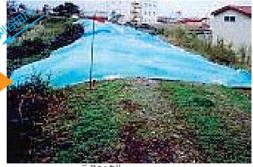
④ 中之島町五百刈応急復旧完了 亀裂部分に石灰を投入し、シート張りを実施(10/26完了)
