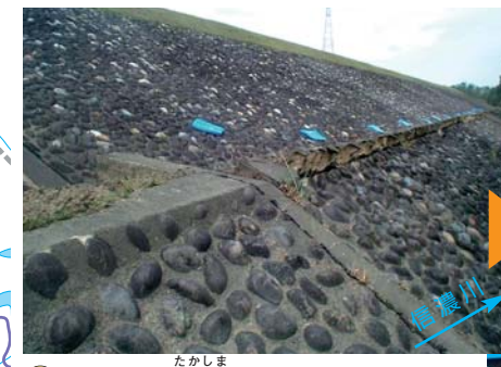
⑥ 十日町市高島護岸損壊 信濃川左岸高島地先の護岸で70mに渡り損壊
