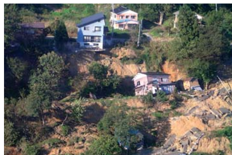
土砂崩れによる家屋倒壊
