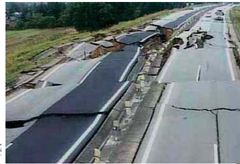
1 関越道の被災状況(堀之内IC~川口IC)
