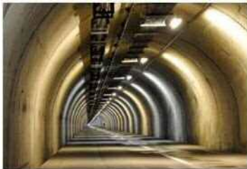
関越トンネル 避難坑
