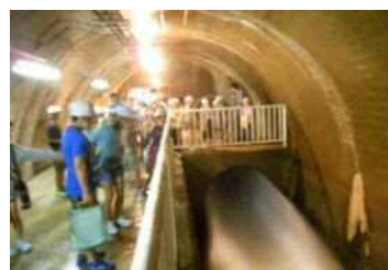
三国川ダム 利水放流水路
