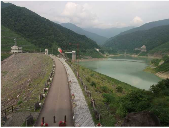
ダム天端の様子(ダム左岸より)
