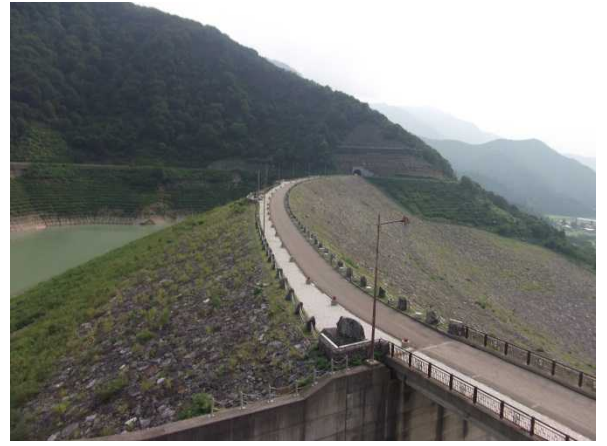
ダム天端の様子(管理所屋上より)
