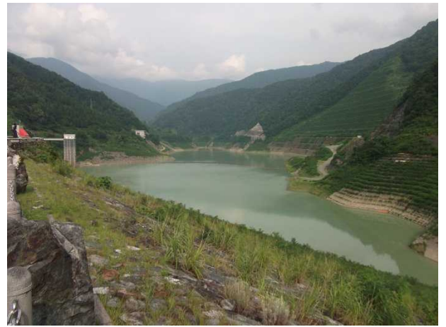
ダム湖の様子(ダム天端より)
