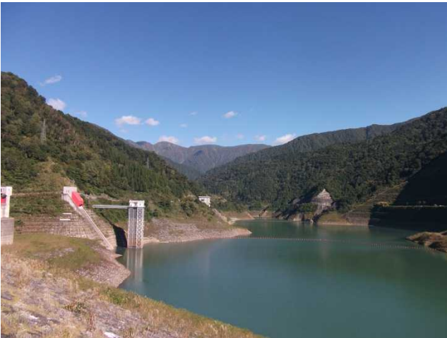
ダム湖の様子(天端より)
