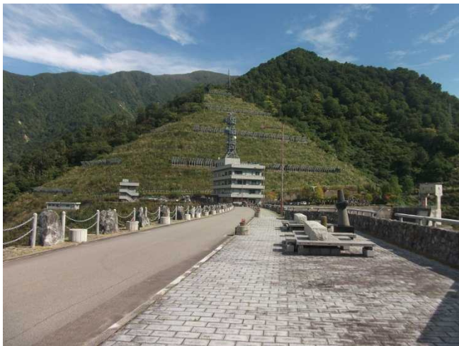
ダム天端の様子(ダム右岸より)
