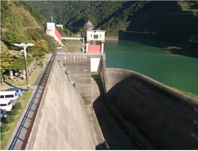
ダム湖の様子(管理所屋上より)
