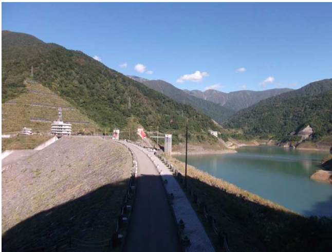
ダム堤体の様子(ダム左岸より)
