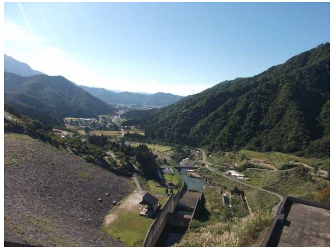
ダム下流の様子(管理所屋上より)
