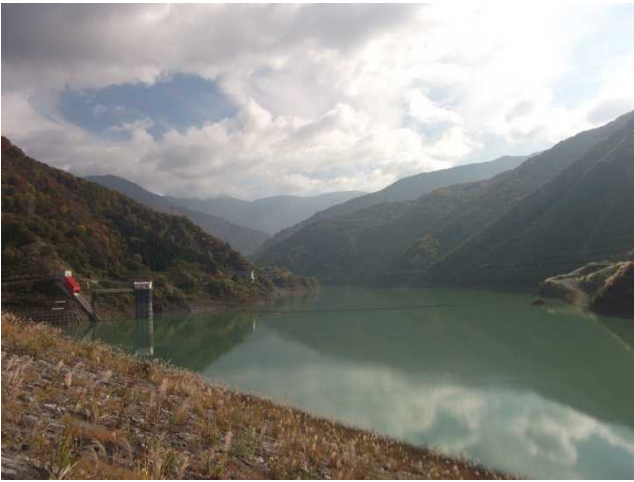
ダム湖の様子(天端より)
