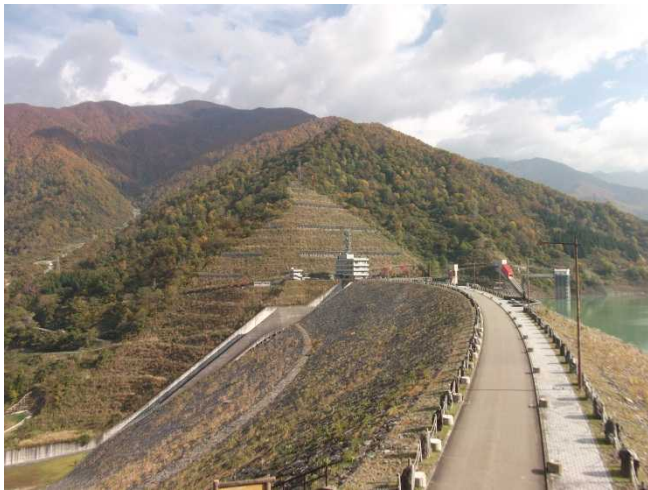
ダム堤体の様子(ダム左岸より)
