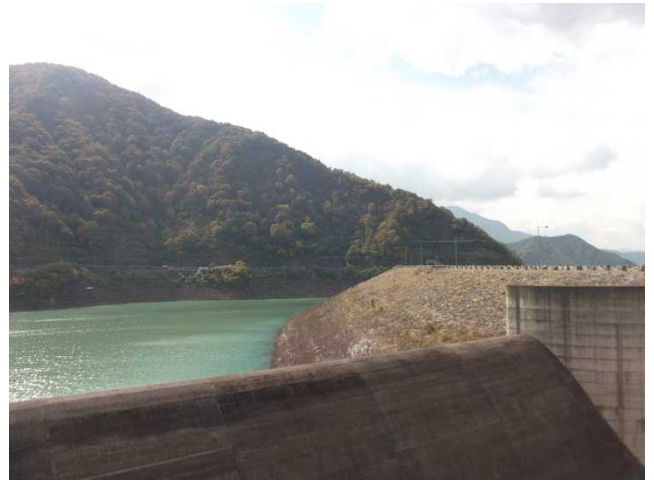
ダム湖上流側の様子(駐車場より)
