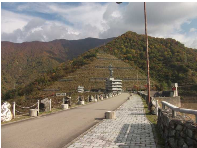
ダム天端の様子(ダム右岸より)
