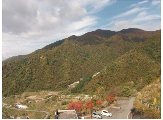
ダム下流側の様子(管理所屋上より)
