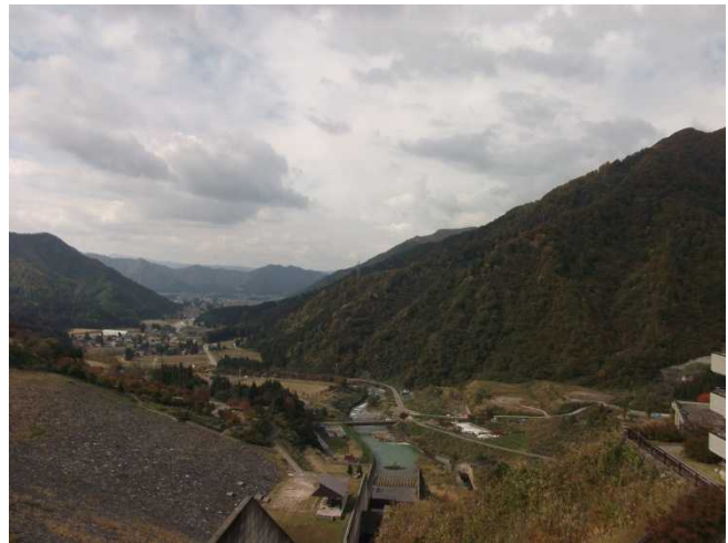
ダム下流の様子(管理所屋上より)
