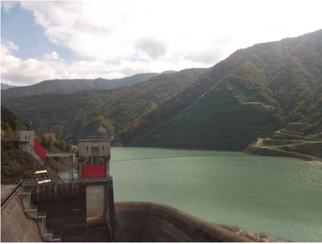
ダム湖の様子(管理所屋上より)
