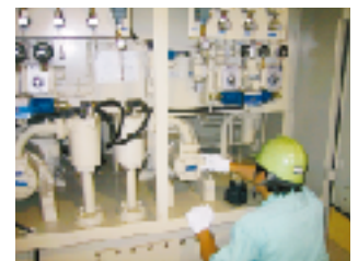
地震時点検の様子
